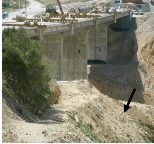
الشكل (6 أ) مناطق القطع لإنشاء الجسر الحديث
