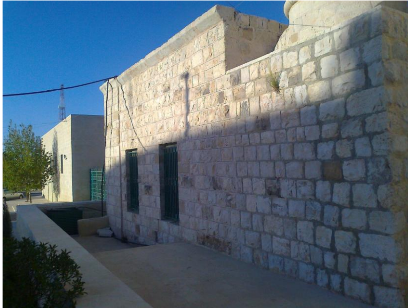
(لوحة:6، الواجهة الغربية للمدرسة - بعدسة الباحث، ويلاحظ اختلاف بناء مداميك المدرسة عن
