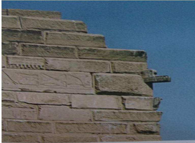
(Fig.3):A water spout from the temple of Elephantine Jaritz, J., Elephantine III. Die Terrassen vor den Tempeln des Chnum und der Satet, AVE 32 , Mainz am Rhein, 1980, pl. 1, 2, 3a and 7; Ludwig, K., Wasserspeier: Form und Funktion eines altägyptischen Architekturdetails , München, 1989, p. 27.
